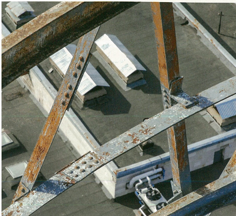
Oberflächen- und Spaltkorrosion im dritten Segment. Der mittlere dünne Ring ist original, die Ringe oben und unten wurden in den 1970er-Jahren eingebaut.
