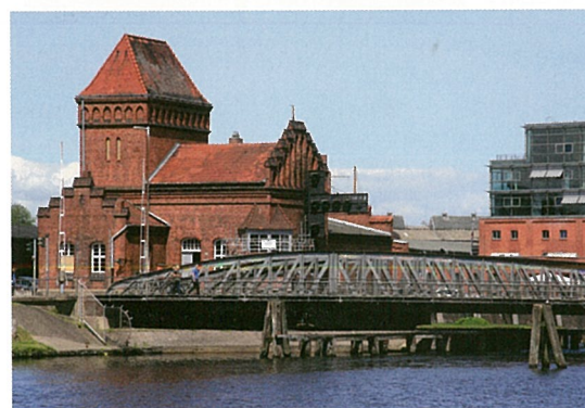
oben: Die Hubbrücke über der Mündung des Elbe-Lübeck-Kanals in die Trave besteht aus drei Teilen: Die hoch gesetzte Fußgängerbrücke (rechts) ist unbeweglich, daneben gibt es je ein Hubbrückenteil für die Straße und die Hafenbahn. Foto: Sven Bardua, 1991
