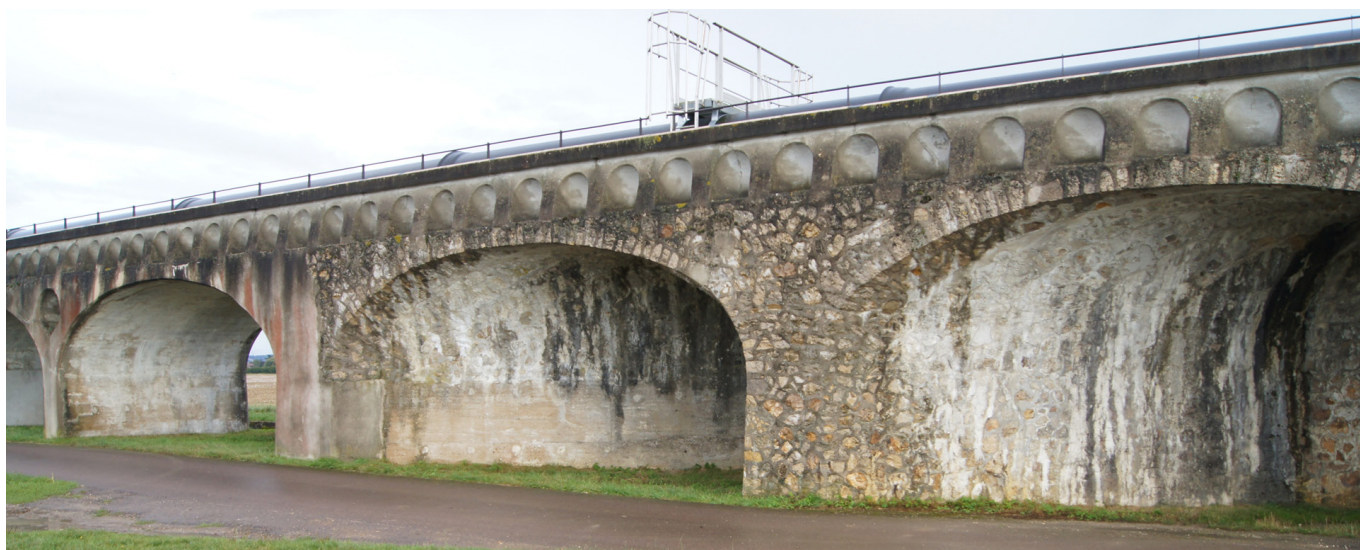
4 Vanne-Aquädukt bei Gisy-les-Nobles, 1872, schiefe Wegdurchführung in Bruchstein
