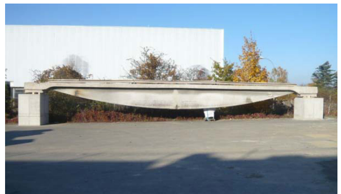
17 Abbruch und Bergung eines Trägers der Fallersleber-Tor-Brücke, 2009
