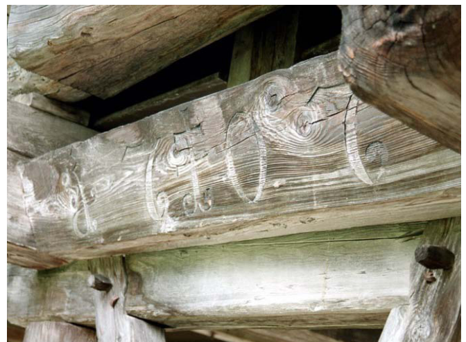
4 Bauinschrift »1707« an einem Querbalken an der Südansicht der Brücke
