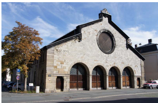
1 Einsteighalle in Hof, Außenansicht von Nordwest, 2012
