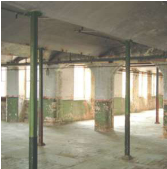
11 North Mill, Belper, von W. Strutt, 1804, uniforme, kreuzförmige Säulen, identisch mit Säulen in Strutts Fabriken in Derby und Milford (1793)
