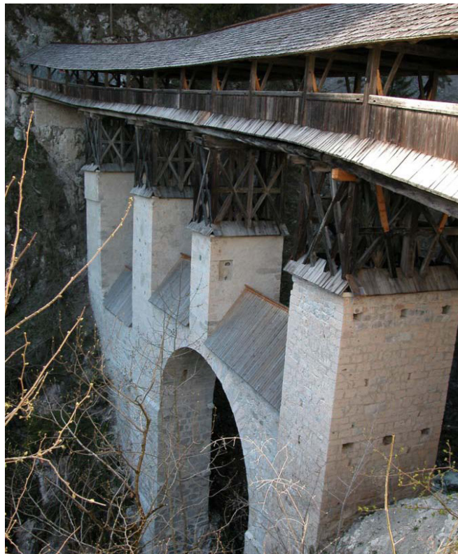
1 Gesamtansicht der Hohen Brücke St. Georgenberg von Südwesten nach Abschluss der Restaurierungsarbeiten
