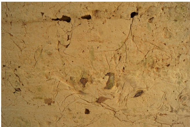
6 Brücke bei Vorwohle, 1877, Detail der Bogenuntersicht
