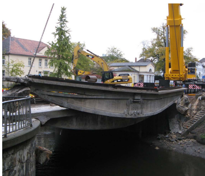
1 Fallersleber-Tor-Brücke, Braunschweig, Abbruch 2009 (Foto: Rosner)
