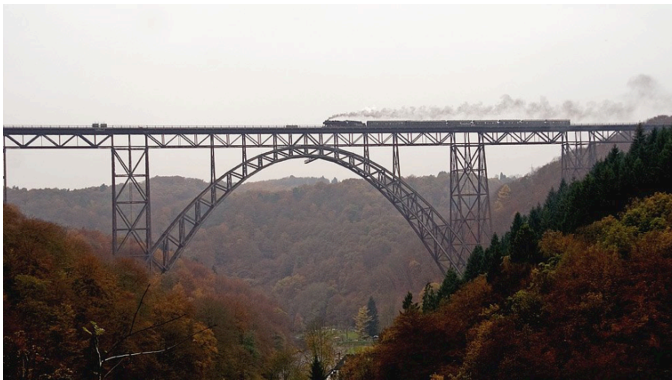
1 Müngstener Brücke über die Wupper, Zustand vor 2012.
