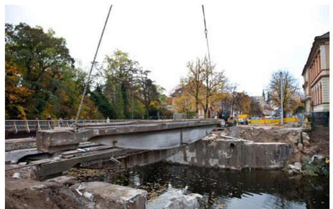
16 Abbruch und Bergung eines Trägers der Fallersleber-Tor-Brücke, 2009
