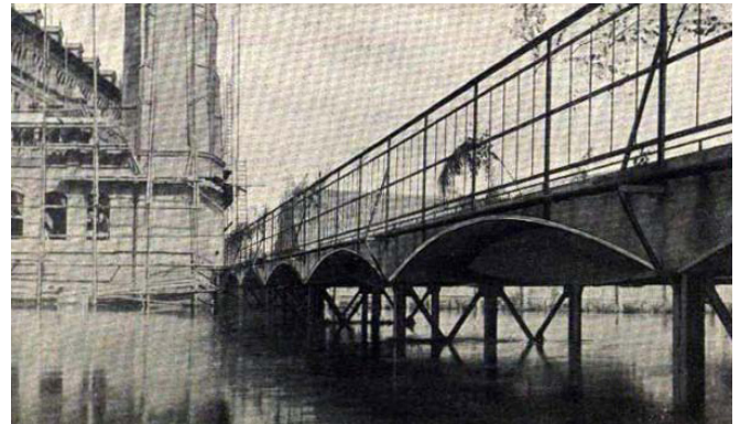
10 Eisenbahnbrücke bei Rüninge, 1894 [Firmenschrift 1904 / Möller 1897, Bl. 17]
