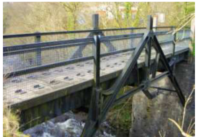
10 Pont y Cafnau, Südwaales, 1793, »Die älteste erhaltene Eisenbahnbrücke der Welt«
