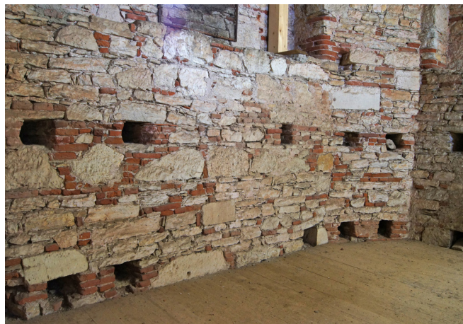
1 Rüstlöcher an der Innenseite des Turms der Hofkirche in Neuburg/Donau (1. Hälfte 17. Jh.)
