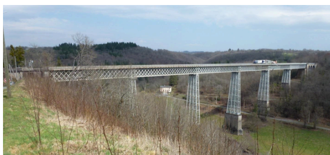
7 Viaduc du Busseau, Revision durch die SNCF, Mai 2012 (Foto: M. Trautz)
