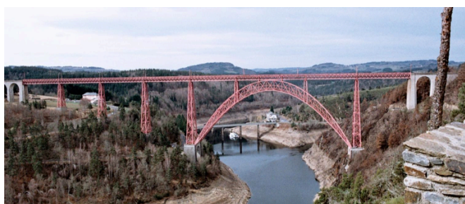
6 Garabit-Viadukt über die Truyère, Zustand Mai 2012 (Foto: M. Trautz)
