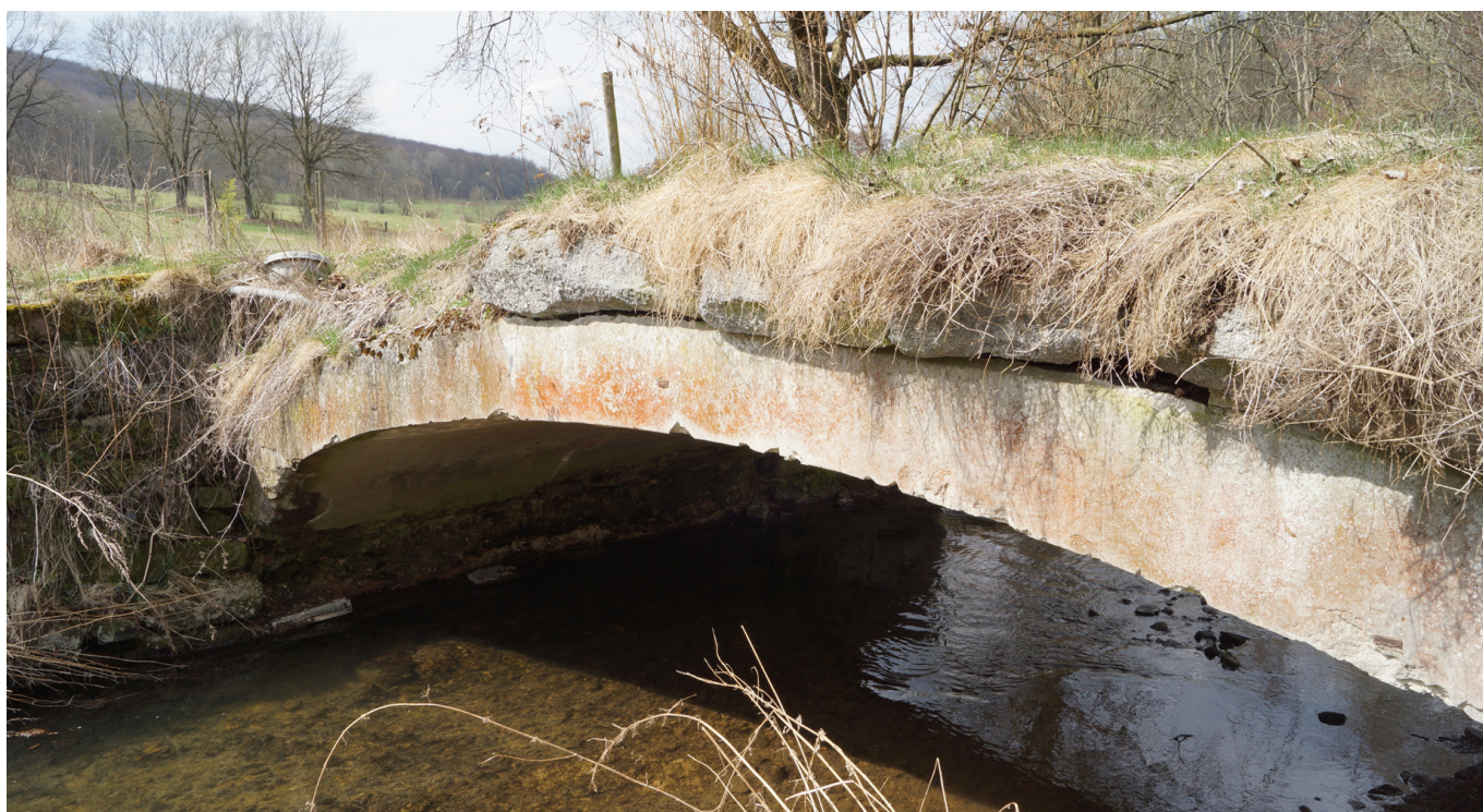
5 Brücke bei Vorwohle, 1877
