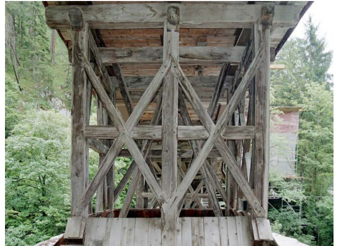
3 Fachwerkaufbau über einem Brückenpfeiler aus jeweils drei in Längs- und in Querrichtung gegeneinander verstrebt Rahmen
