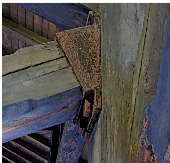
4 Einsteighalle in Hof, Balkenschuh zwischen Strebe und Hängesäule, 2012
