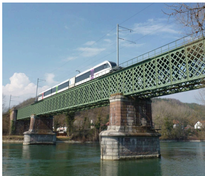
2 Eisenbahnbrücke über den Rhein bei Waldshut, Zustand 2012
