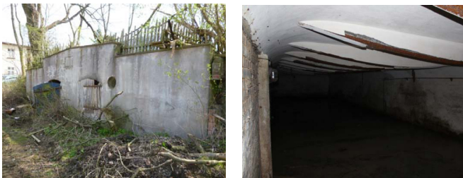
6/7 Kellerdecke der Firma Brachvogel, Baujahr 1899, Zustand 2013
