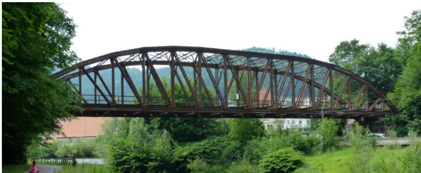
4 Eisenbahnbrücke über die Nagold bei Unterreichenbach, Zustand 2011 (Foto: K. Trautz)
