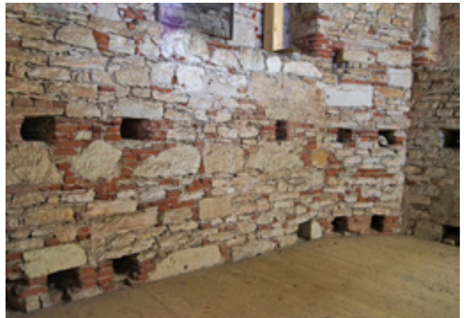
1 Rüstlöcher an der Innenseite des Turms der Hofkirche in Neuburg/Donau (1. Hälfte 17. Jh.)
