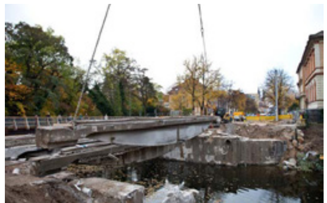
16 Abbruch und Bergung eines Trägers der Fallersleber-Tor-Brücke, 2009
