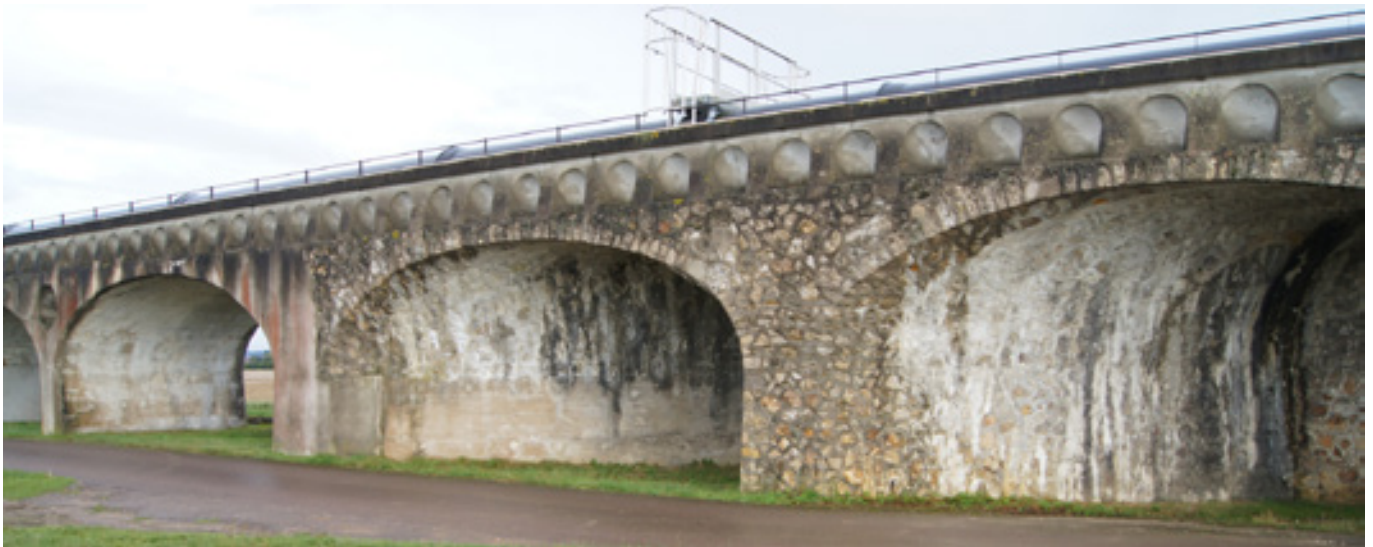
4 Vanne-Aquädukt bei Gisy-les-Nobles, 1872, schiefe Wegdurchführung in Bruchstein
