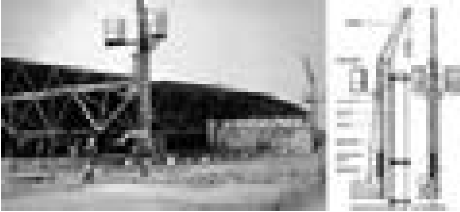
Abb. 8 Erprobung des kranlosen Hubprozesses, um 1980; elektromechanisches Hubaggregat
