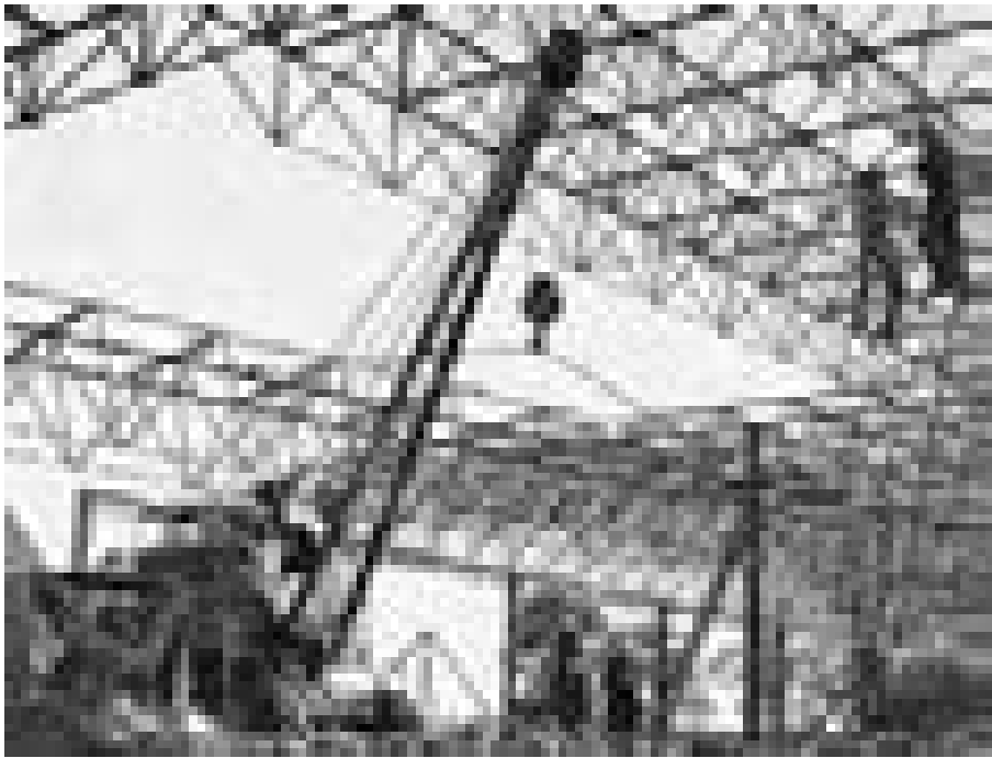
Abb. 5 Montage eines Stabrostes aus dem Space-Deck-System
