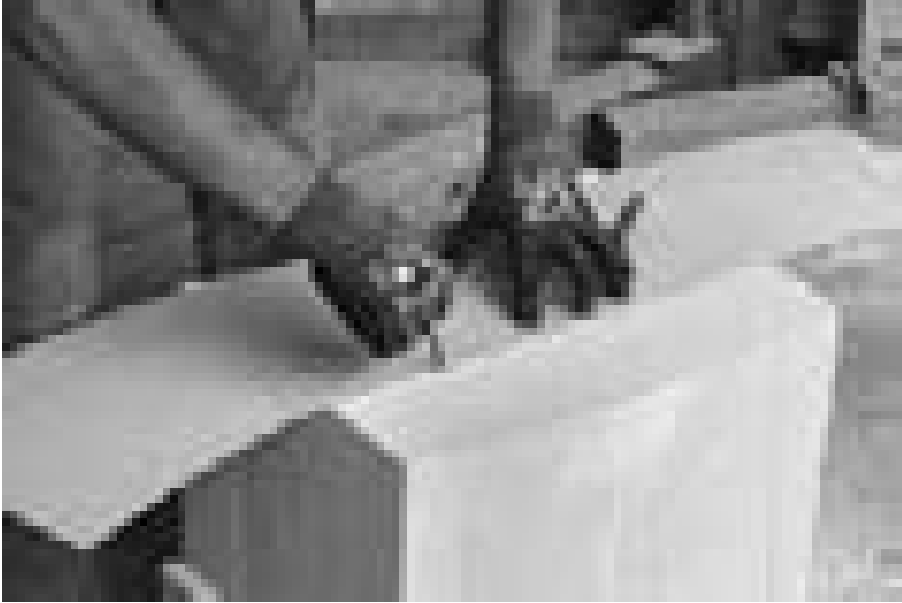
Abb. 6 Verwendung einer biegsamen Schablone zum Anreißen von räumlich gekrümmten Bogensteinen, hier bei der experimentellen Nachbildung des Kaminbogens in der Schönburg: Mit der Abwicklungsschablone werden die Ränder der Bogenlaibung angerissen, deren Fläche in diesem Fall nur leicht gekrümmt ist
