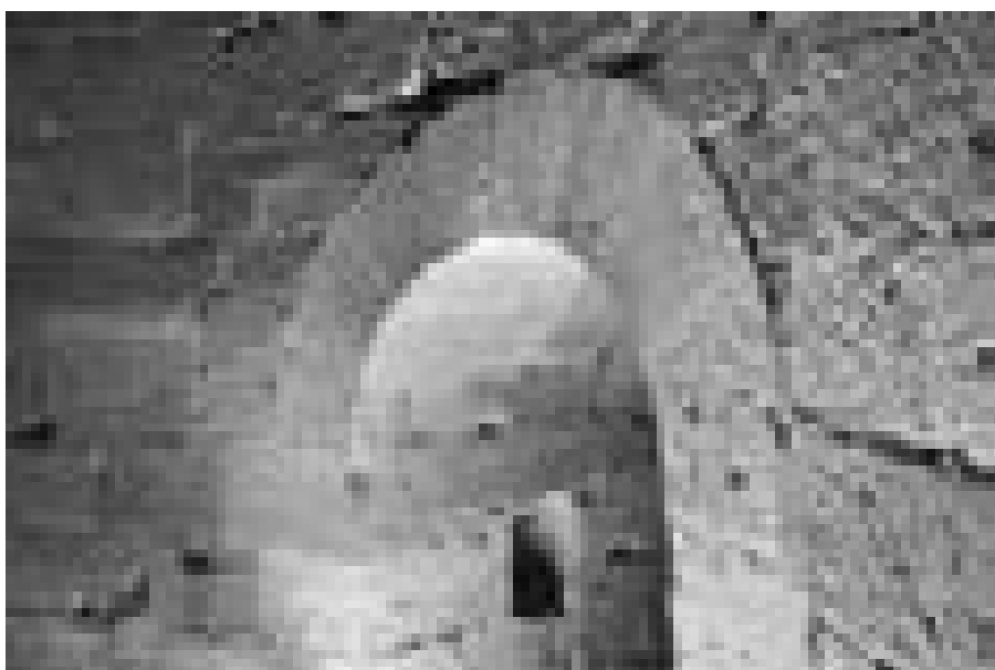
Abb. 7 Räumlich gekrümmter Bogen über der Eingangstür im ersten Obergeschoss des Bergfrieds
