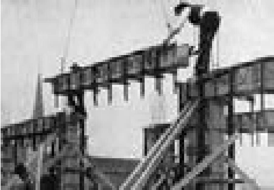
Abb. 5 Verwendung von Hico-Schalungsträgern, Ausführung: Zimmerei Goldes
