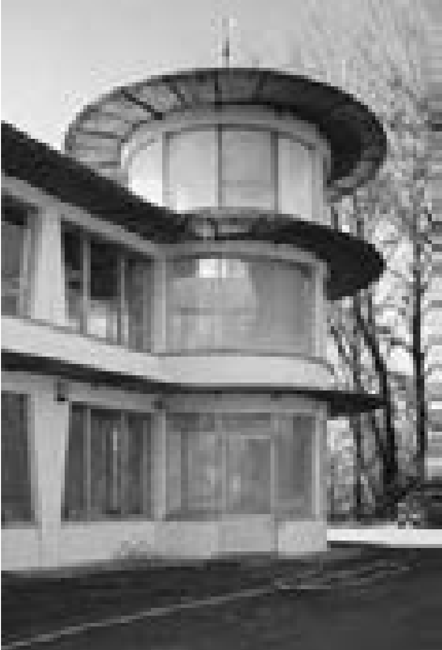
Abb. 3 Heutiger getrüübter Zustand der gebogenen Acrylglasplatten
