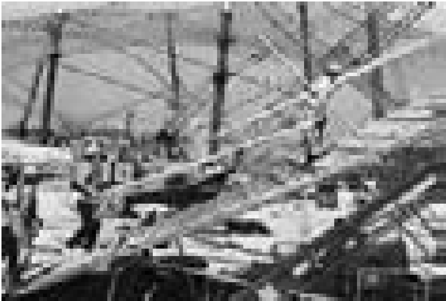
Abb. 5 Baustelle, Transport der Acrylglasplatten auf das Olympische Dach 1971 in München
