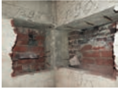
Abb. 8 Raumseitige Bauteilöffnung: Außenwand Stahlbetonskelett und dreischaliges Mauerwerk
