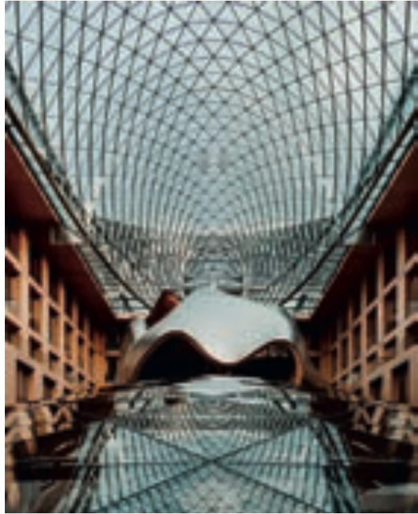
Abb. 4 Deutsche Zentralbank, Berlin, Gitterschalen über dem Atrium, um 1998
