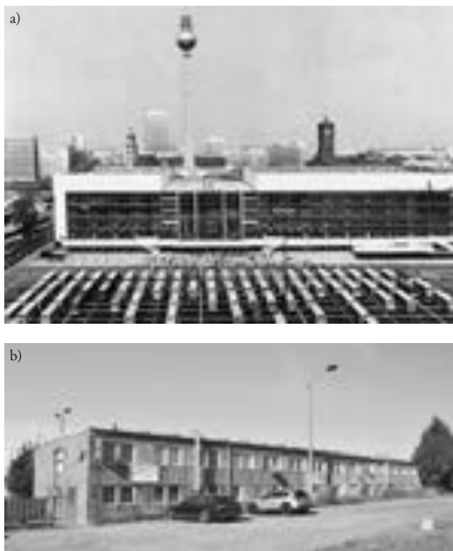
Abb. 2 Bauten des ›VEB MLK‹: (a) Palast der Republik Berlin, ausgeführt 1973–1976; (b) ›Mehrzweckgebäude Typ Berlin‹ ausgeführt mit zwei Geschossen in Magdeburg, Nachnutzung durch Bistro mit Photovoltaikanlage
