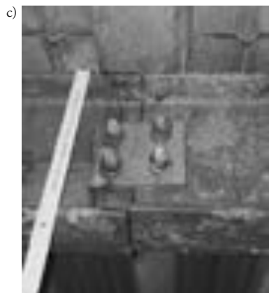
Abb. 8 ›Mehrzweckgebäude Typ Berlin‹: (c) Koppelpunkt der Halbrahmen; (d) Schnitt mit Profilwahl
