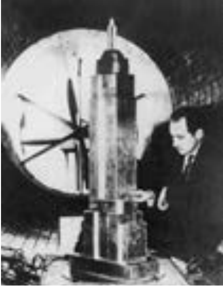
Abb. 5 Modell im Maßstab 1:250 des Empire State Building im Windkanal des National Bureau of Standards (1932)
