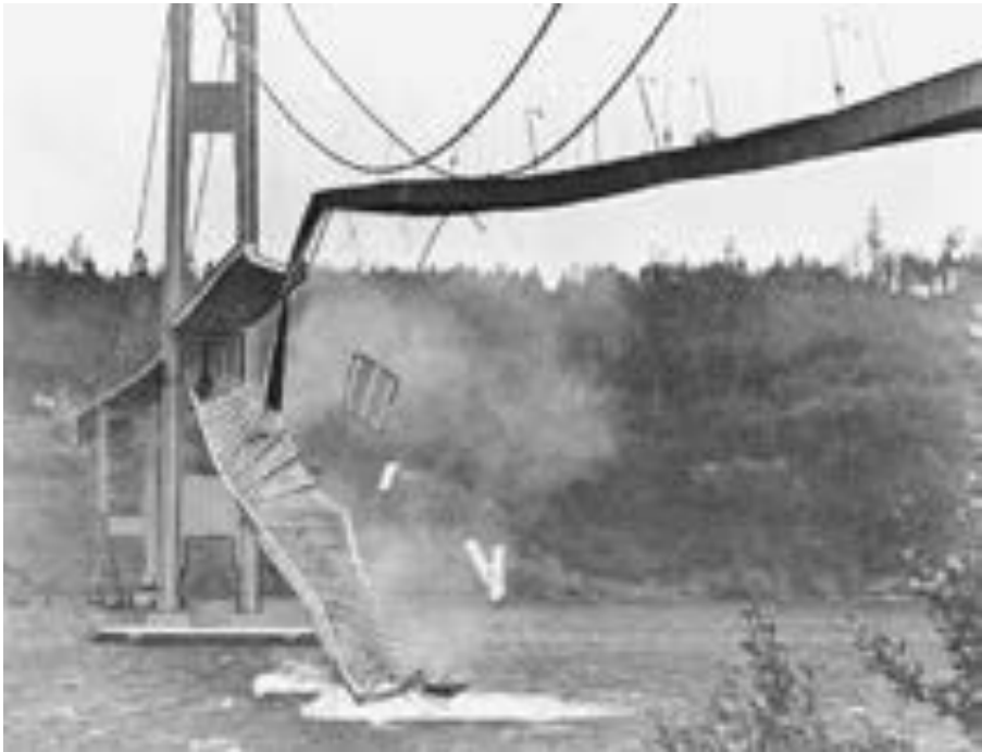
Abb. 1 Tacoma Narrows Bridge in Washington nach dem Einsturz 1940, Planung: Leon S. Moisseiff, Bauzeit: 1938–1940
