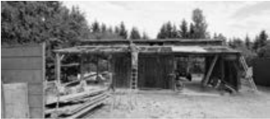
Abb. 5 Kollersried, Teils demontierte Gebäudehülle, 2022
