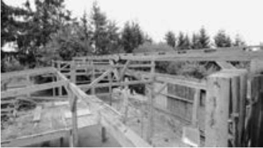
Abb. 8 Kollersried, Längs- und Querverbände des Holzrahmens, 2022
