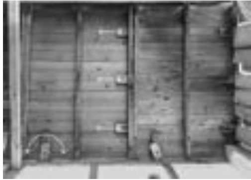
Abb. 7 Kollersried, Zwei Laternendachtafeln in der Untersicht, 2022
