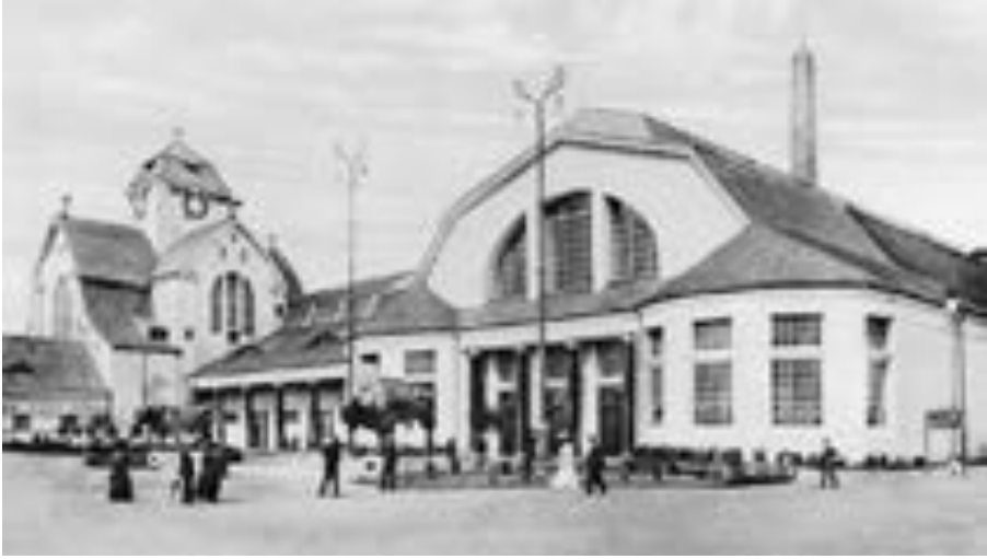
Abb. 2 Blick von Süden auf die Deutsche Abteilung, im Vordergrund der Eingang zur Kraftmaschinenhalle (1910)
