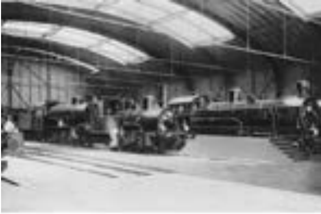
Abb. 4 Eisenbahnhalle, Innenraum und Haupt- fassade (1910)
