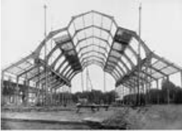
Abb. 5 Kraftmaschinenhalle im Bau (1909) und Innenraum zur Rückwand (1910)
