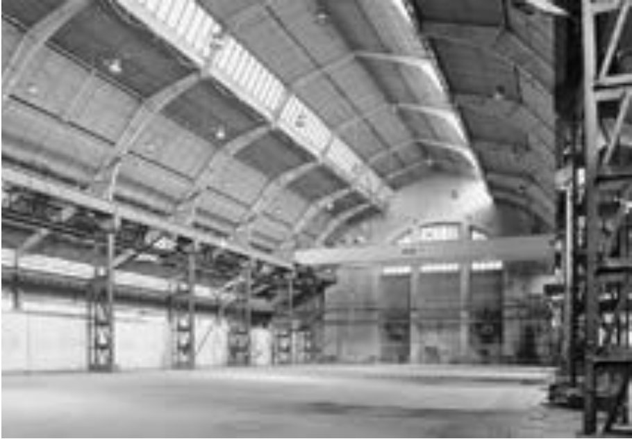
Abb. 9 Innenraum der ehemaligen Kraftmaschinenhalle am heutigen Standort im Gewerbegebiet Dessau-Mitte, Dessau-Roßlau
