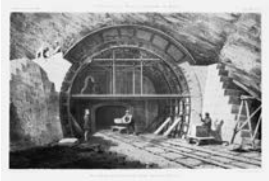
Abb. 7 Portalbau und Einbruch beim Ippenser Tunnel
