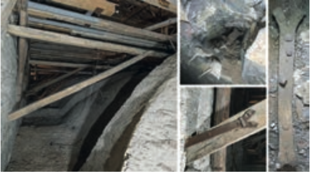
Abb. 8 St. Margareta, Břevnov, 1709–1722; Zugelement; links: durchgängiger horizontaler und angeblatteter diagonaler Holzbalken; Mitte oben: loses Eisenband in leerer Balkenöffnung; Mitte unten: Verankerung eines diagonalen Balkens in der Außenmauer mit Eisenband; rechts: loses Eisenband, Gesamtansicht
