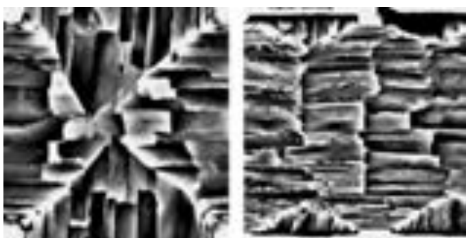
Abb. 2 Tournus, Saint-Philibert, Gewölbeaufsicht eines Kreuzgewölbes der zentralen Halle der Krypta (links) und des Tonnengewölbes des Umgangs (rechts), die Schalungsspuren wurden durch digitale Analysen hervorgehoben
