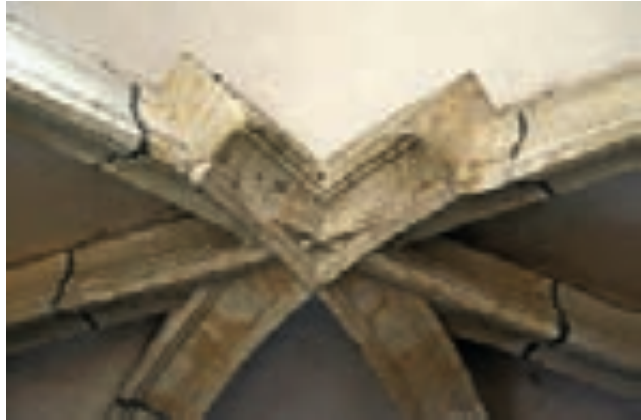
Abb. 3 Prag, Dom St. Veit, Schlingrippengewölbe über der Orgelepore; Rippenknoten mit diagonalen Rippen mit einem Steg und zwei gekappt endenden Kastenrippen mit je zwei lateralen Rippenstegen
