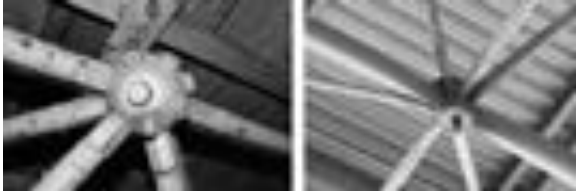
Abb. 1 Raumfachwerksysteme, links: System ›Weimar‹ (HAB Weimar, Institut für Industrie- und Ingenieurhochbau), rechts: System ›IfI‹ (Deutsche Bauakademie Berlin, Institut für Industriebau)
