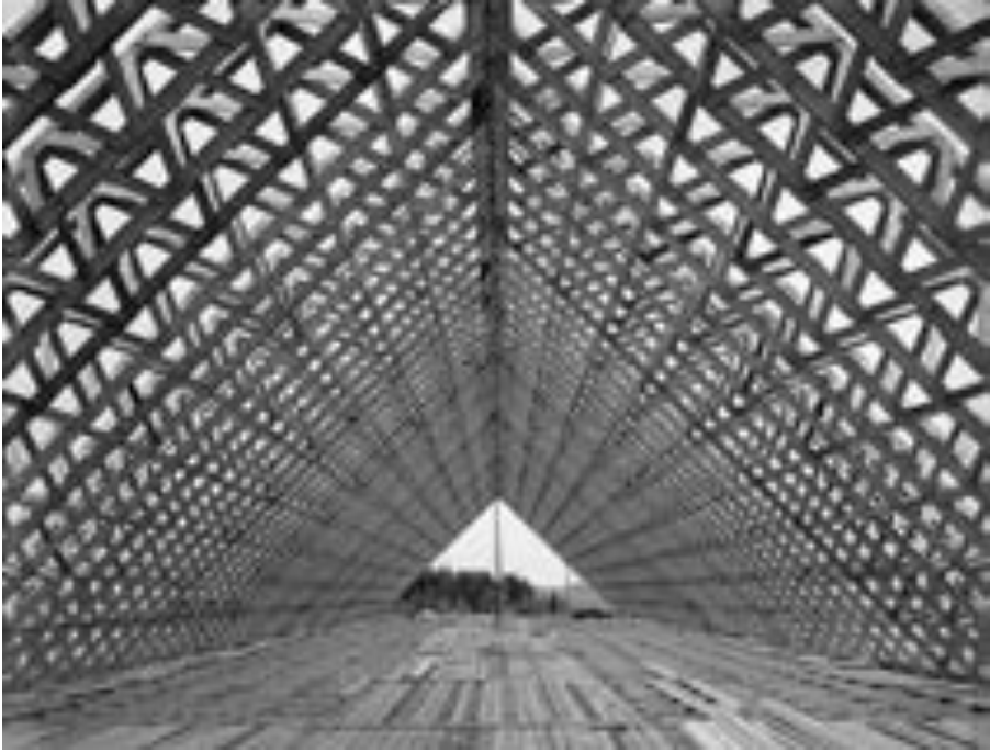
Abb. 1 Die V-Rippe Krohers als Sparren- und Deckenträger, Autobahnmeisterei München-Obermenzing
