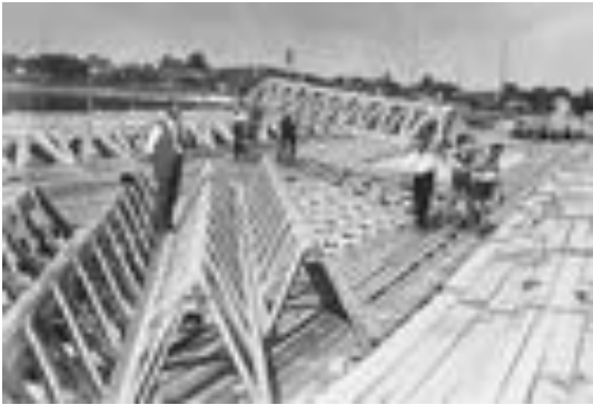
Abb. 2 Die vorgefertigten Rippen des Kroher-Systems ließen sich auf der Baustelle stapeln und leicht transportieren
