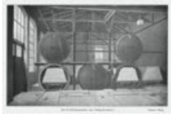
Abb. 4 Historische Härtekesselstation zur hyperbaren Dampfhärtung von Kalksandsteinen, 1920er-Jahre
