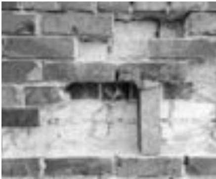
Abb. 1 Hamburg-Jarrestadt, Semperplatz: Klinkerfassade mit tragender Kalksandsteinschale, Siedlungsbaugebiet nach Plänen von Fritz Schumacher, 1927
