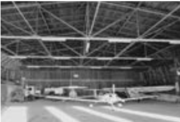
Abb. 2 Innenansicht eines Hangars am Flughafen Innsbruck
